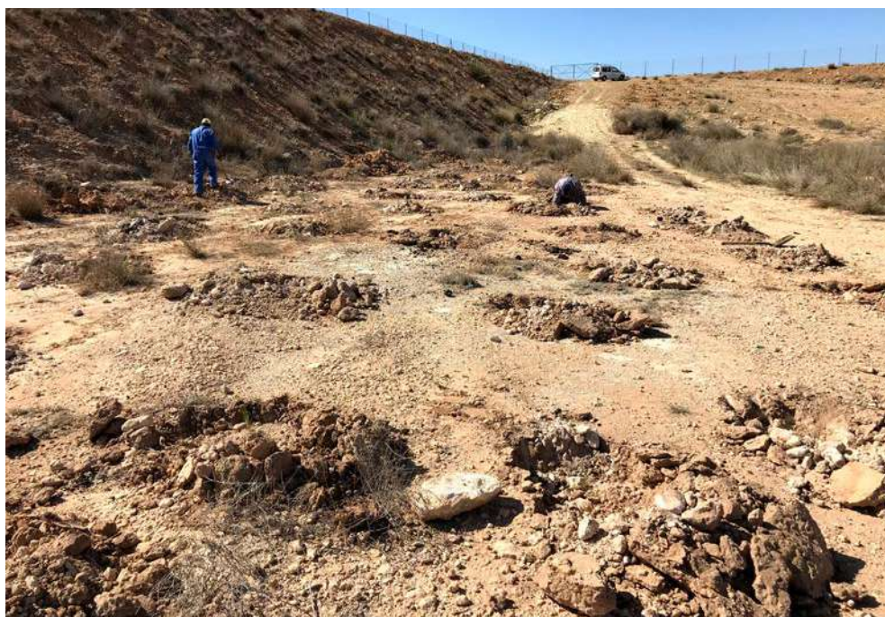
Plantación de talud de embalse de riego sobre hoyos abiertos con retroexcavadora en la explotación García Vargas (Jumilla). Foto Sacha Dauriac.
