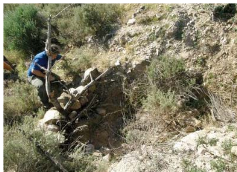
Dique base de cárcava.
