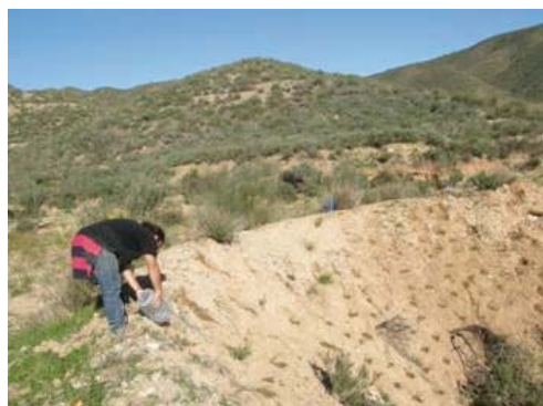
Medida 6. Fijación de un talud.
