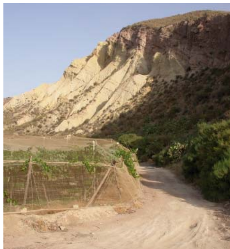
Las transformaciones a regadíos pueden presentar problemas de erosión.
