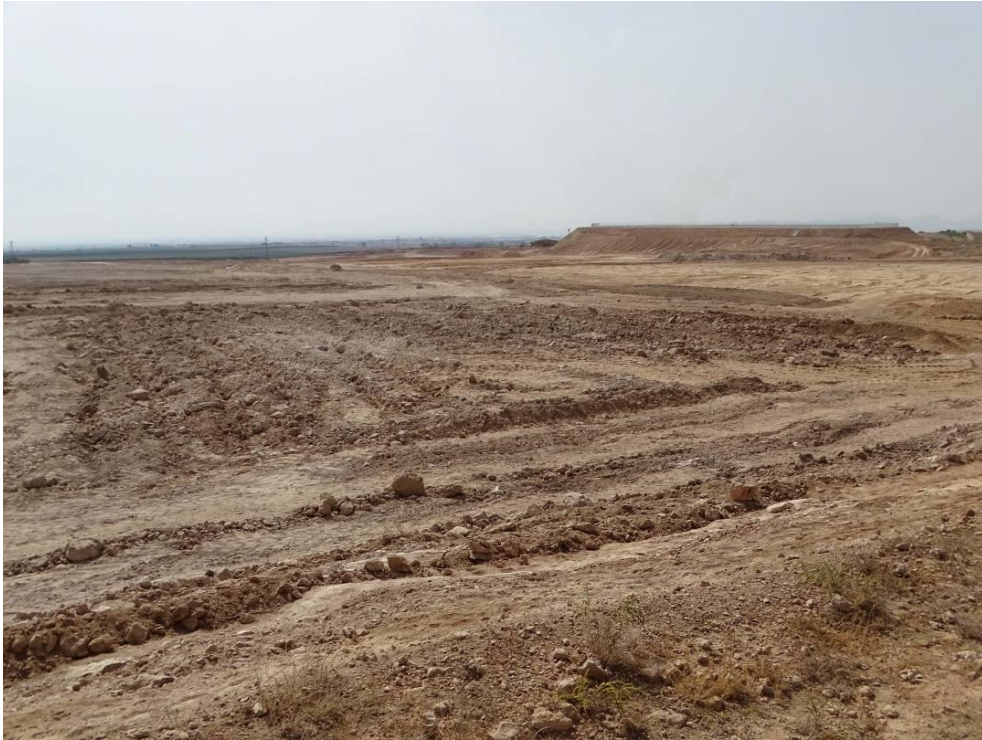
Imagen 10. Roturación y construcción de embalse junto a la población de La Murta (agosto de 2017) Fuente: P.García/ANSE
