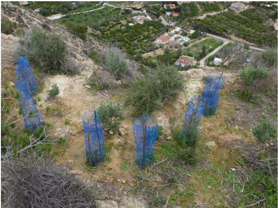
Dique y plantación en la coronación de una cárcava para evitar la salida de escorrentías de la terraza. Obsérvese como se han respetado las albardas existentes en el inicio de la cárcava
