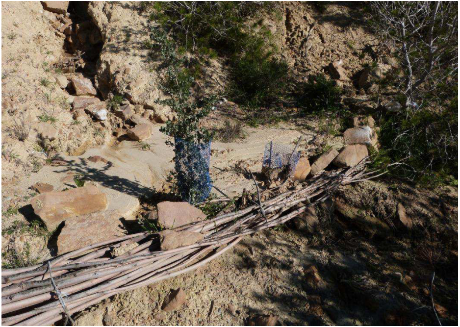
Fajina de ramas de morera acompañada de Atriplex halimus instalada para la captura de sedimentos y escorrentías procedentes de una pista. Obsérvese la acumulación de sedimentos finos aguas arriba de la fajina
