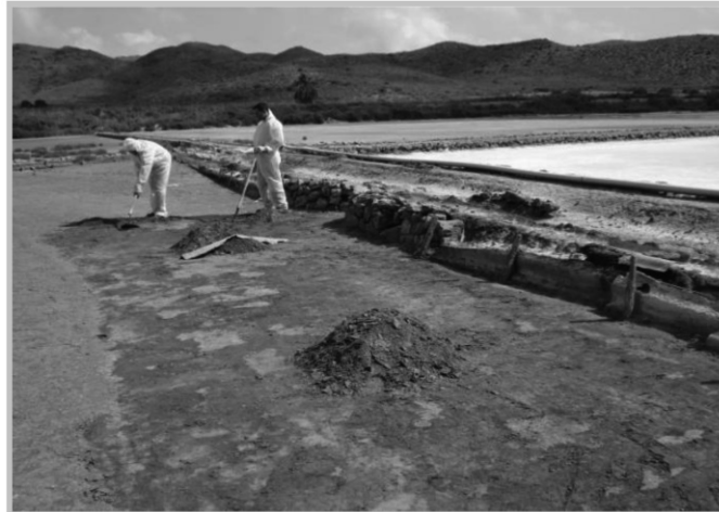
Figura 1: Adecuación de infraestructuras productivas.
