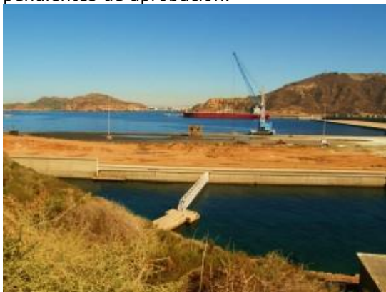
Obras de ampliación de la dársena de Escombreras han acabado con el carácter insular de la Isla de Escombreras
