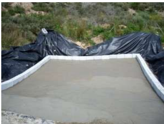
La charca se construyó sobre una lámina impermeable /ANSE
