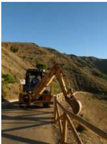
Retroexcavadora abriendo hoyos en el parque minero
