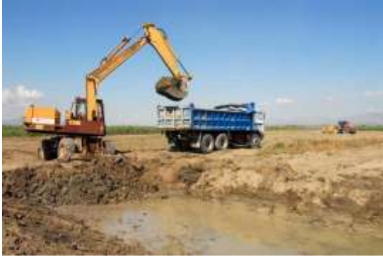
Obras de excavación del humedal/ANSE
