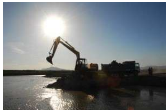
Maquinaria excavando el humedal/ANSE
