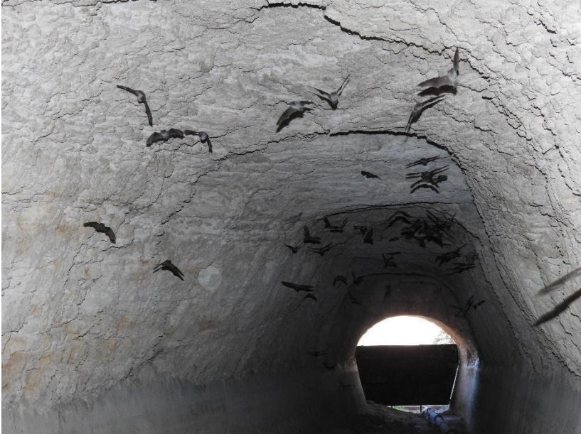
Interior de un túnel de una antigua conducción de agua ocupado por Myotis capaccinii , junto a otras especies de murciélagos cavernícolas (foto: A. Guardiola).
